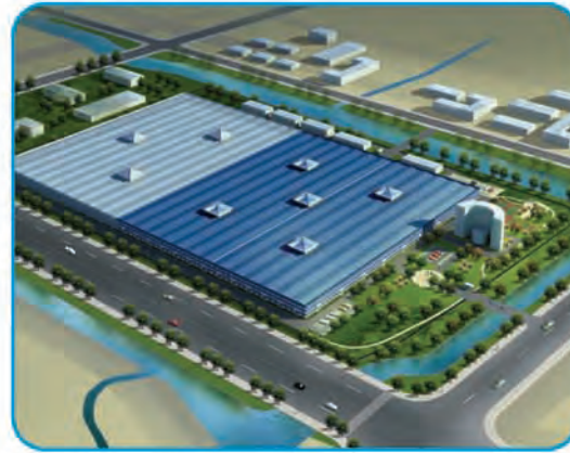
沪临重型金属加工有限公司联合厂房
