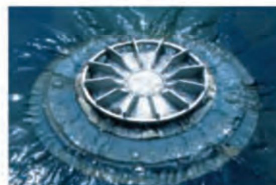
有空气挡板： 产生虹吸流，无漩涡
