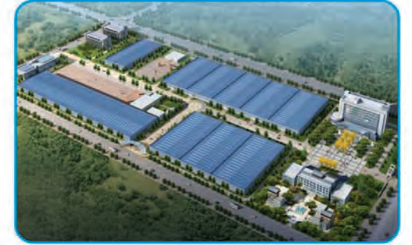
上海天合石油工程股份有限公司机械加工厂房
