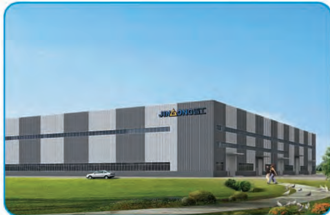
福建晋工机械有限公司联合车间1、2厂房
